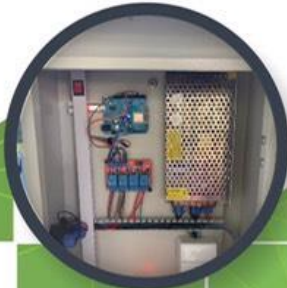
การเชื่อมต่ออุปกรณ์ภายในกล่องควบคุม
