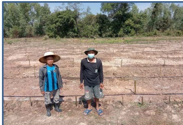
การวางระบบน้ำ
